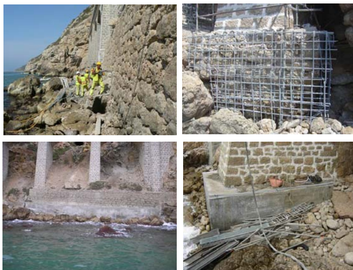
Fig 2. Situaciones previas y posteriores a la ejecución de los zunchos.
