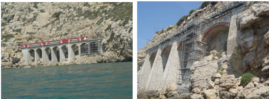
Fig 1. Vista general de las estructuras.
