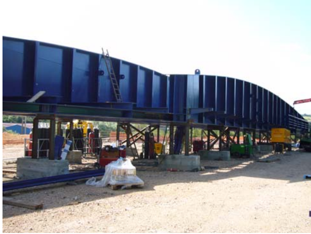
Figuras 7 y 8. Estructura Eje 2. Armado en playa de montaje
