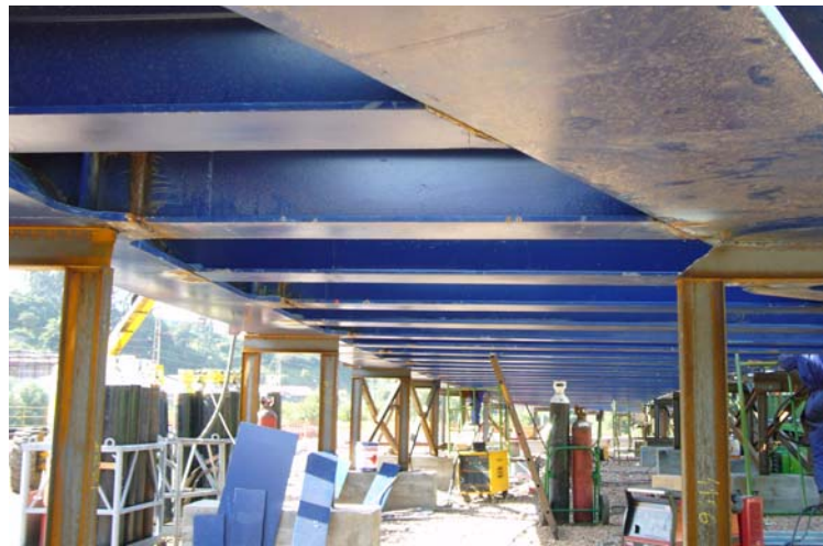
Figuras 9 y 10. Rigidizadores y vigas transversales.
