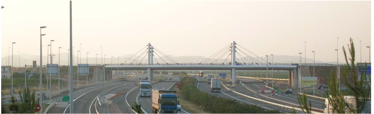
Foto 1. Vista general del Viaducto sobre el By-Pass
